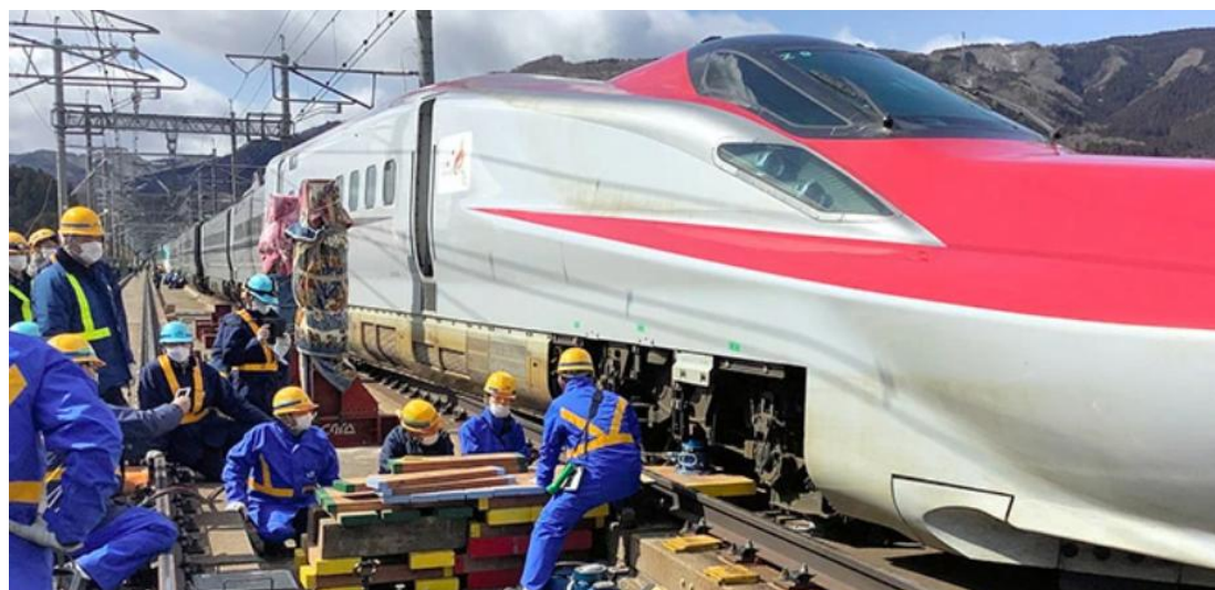
Trabajadores comienzan a instalar gatos hidráulicos para levantar los vagones del tren bala de la línea Tohoku Shinkansen que se descarrilaron producto de un terremoto, y así reanudar los servicios antes de la Semana Dorada. Fuente: East Japan Railway Co., marzo de 2022.
